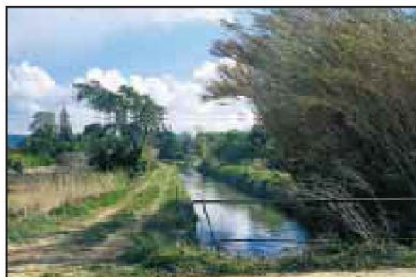
Berges d'un canal de l'étang de Marseillette, Aude.
