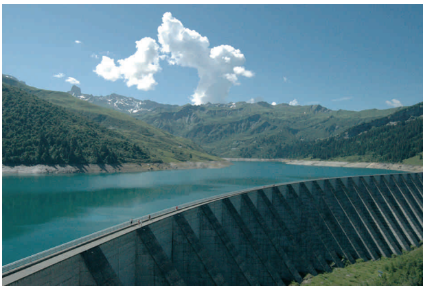
Barrage de Roselend (73)
