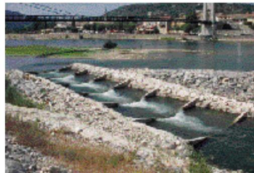
Passe à seuils successifs à échantures triangulaires de Saint Martin-d'Ardèche. Le profil en V des parois des bassins associé à une échanture centrale permet de maintenir la passe fonctionnelle pour une grande plage de débits (photos GHAAPE et D. BARIL, CSP).
