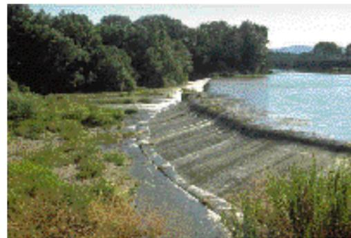
Seuil béton de la microcentrale de Puychéric sur l'Aude (photo D. BARIL, CSP).
