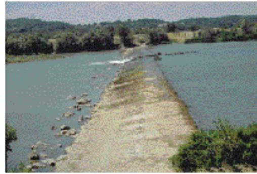
Seuil béton de Comps sur le Gardon (photo D. BARIL, CSP).
