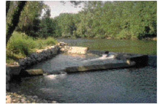
Photos de prébarrages (photos GHAAPPE) : dans les 2 cas, l'implantation des prébarrages est correcte, ces dispositifs étant situés au niveau de la partie la plus amont de l'obstacle, là où vont se concentrer les poissons.
