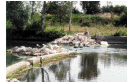
Seuil de Terre-de-Port sur le Vidourle. Une brèche, apparue lors d'une crue, permet la libre circulation des poissons (photo MRM).
