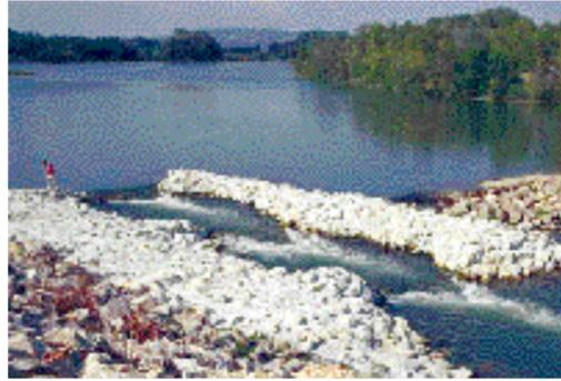
Passe à seuils successifs à échantures triangulaires de Codolet sur la Cèze (photo MRM).
