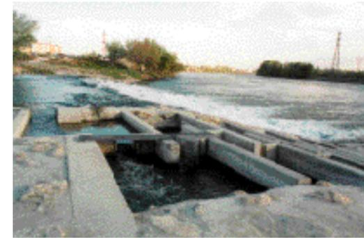
Piège installé au niveau d'une passe à poissons sur l'Ouveze (Photo D. BARIL, CSP).
