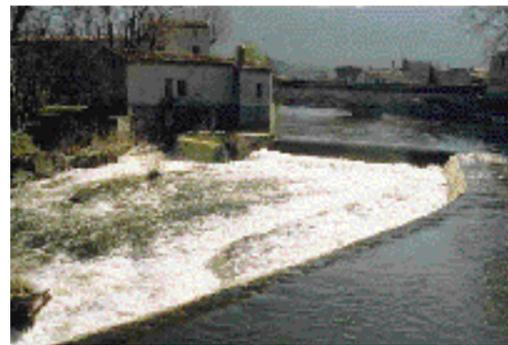
Seuil béton de la microcentrale de Quillan sur l'Aude (photo D. BARIL, CSP).
